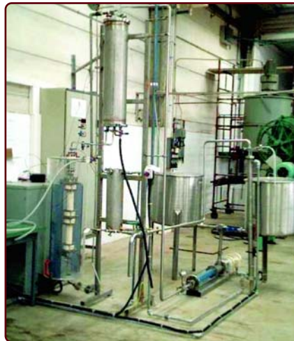
Exemplo de instalação à escala piloto
